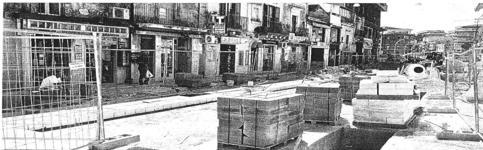
Il cantiere di via Roma: è iniziata la posa delle basole anche nel tratto tra via Sant'Anna e via Salvatore
